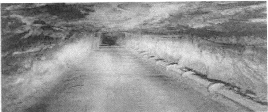
Bergwerksstollen in Sondershausen
